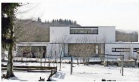
Für dieses Projekt an der Malmveder Straße in Eupen wurde Sebastian Borch ausgezeichnet.
